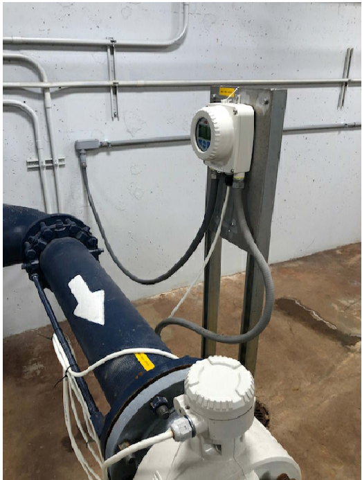
2 FLOW METER (1) SCALE: NONE E
