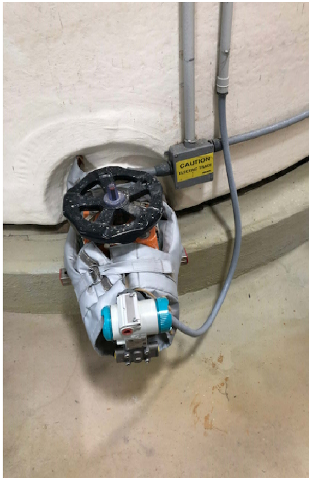
1 PRESSURE TRANSMITTER SCALE: NONE E
