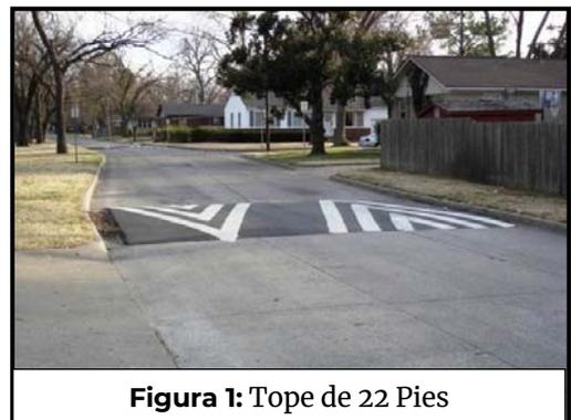
la calle. Un borde cónico cerca del bordillo permite la evacuación de las aguas pluviales. Los reductores de velocidad instalados por la ciudad de Tulsa tienen una longitud de veintidós (22) pies al cruzarlos y una altura de tres pulgadas y media (3 1/2”).
